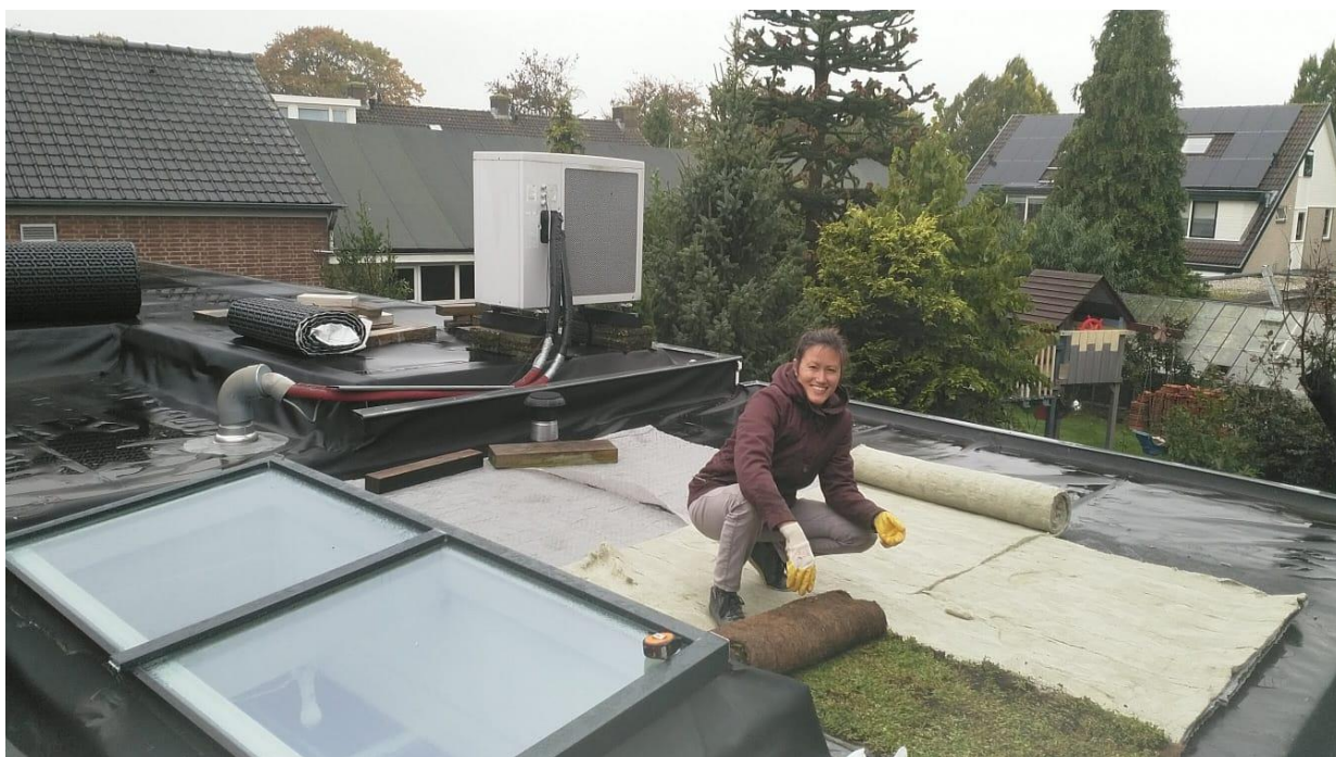
Onze collega Jessica Doorn isoleerde haar platte dak met platen hennep van 24 cm en werkte dit vervolgens af met groen.
